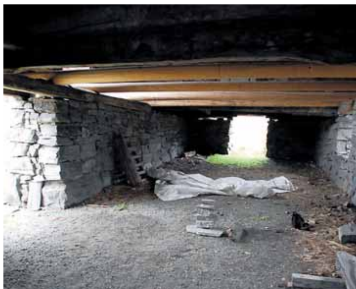
Halvgjort arbeid: Det store steinfjøset står tilbake som et tomt skall.
