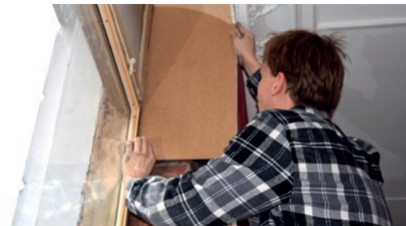
Møbelsnekker Rune Hallberg fra Kris og Kjells Møbelsnekkeri reparerer den gamle vindusåpningen. Alt gammelt treverk var fjernet og må lages på nytt.
