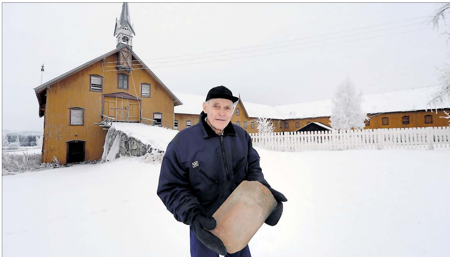
VIL HA FOKUS PÅ LÅVEN: Tord Kristian Horne sier han ikke kan ta kostnaden for å ta ned og lagre taksteinen fra Hornelåven. Poenget er å bevare byggingen. FOTO: TROND LILLEBO
