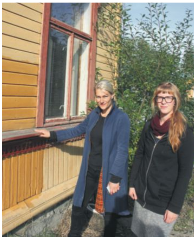
Mette Bye og Nina Benden ved den mest verneverdige bygningen på Svartlamoen. Veggen blir måla med diffusjonsopen linolje – det er miljøvenleg og motverkar røte.
