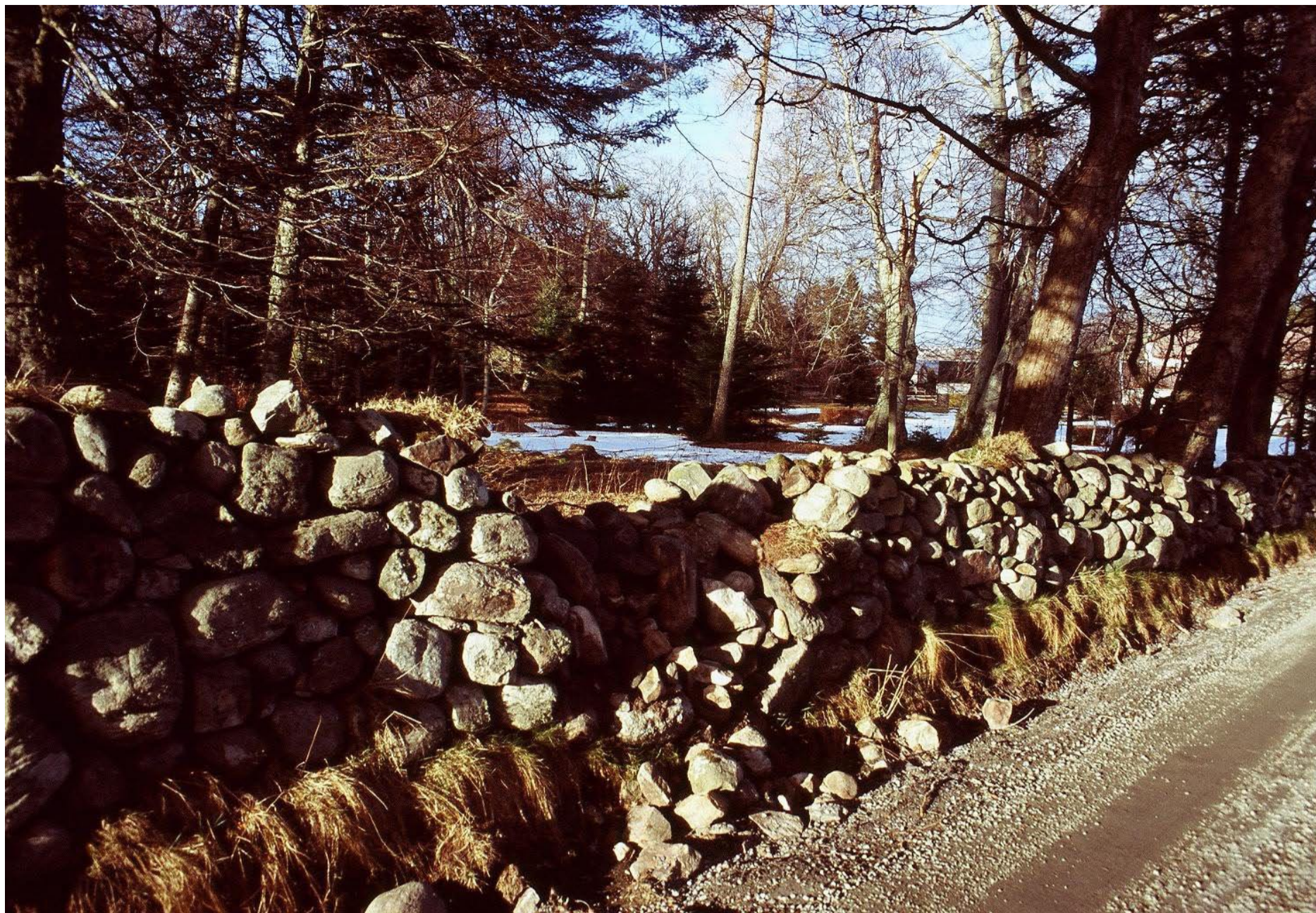
EVIG: Han står lenger enn skigarden, men også muren treng reparasjon og vedlikehold. På Averøy i Møre og Romsdal skal muren ved Bremnes gard og kyrkjeområde restaurert under seminaret i regi av «Bredablikk – forum for kulturarv og forvaltning av verdiar».
