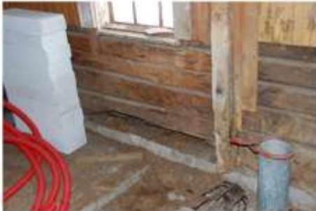
Det er råteskader flere steder i bunnstokkene i det gamle tømmerfjøset.
