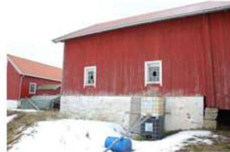
Plasseringen av en ny kjøreport til fjøset vil trolig passe best å ha på baksiden av fjøset. Eksisterende dor til kjelleren bør da mures igjen, og en ny port bør plasseres mellom vinduene på bakveggen. Innredningens plassering vil selvfølgelig innvirke på hvor porten bør stå.
